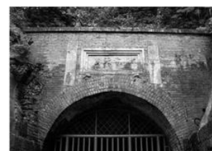
丁.獅球嶺隧道（最早火車隧道）
