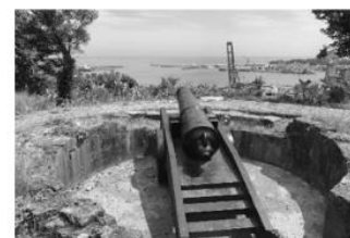
戊.基隆二沙灣砲台
